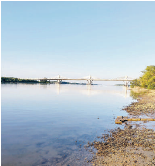
Romanya ile Bulgaristan'ı Tuna Nehri üzerinden birbirine bağlayan Calafat-Vidin köprüsü. Kontrol, köprünün ücret istasyonu yakınında gerçekleştirildi. Foto: Arşiv- Alexandraioana.lungu / Wikimedia Commons
